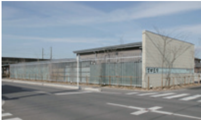
吉田医院(栃木県) 設計事務所 ビィフォックス株式会社 建設会社 山形建設株式会社 加工店 株式会社松山 使用製品 NL300、汎用材
