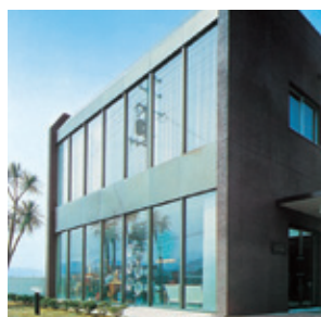
(株)伊達屋号本館(福島県) 設計 内田設計事務所 施工 東開商事(株)、 (株)ヤマト 使用材料 ローライズ2500
