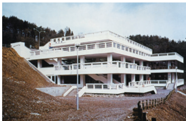
(株)浄土が浜ターミナルビル(岩手県) 設計 鹿野設計事務所 施工 (株)ヤマト 使用材料 ナローライン300、400、190ドア、SK12引戸、7K-RM
