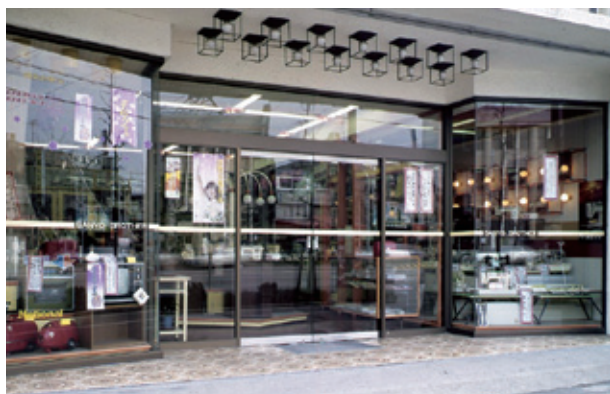
電化製品 山陽ブラザー販売(株)(岡山県) 設計 (株)土井 施工 双葉商会(株) 使用材料 ナローライン400
