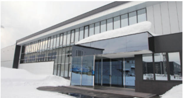
光駿輸送株式会社 大曲配送センター(北海道) 設計事務所 一級建築士事務所 アトリエプラス 建設会社 中井聖建設株式会社 販売店 協和サッシ工業株式会社 使用製品 アソート、NL300、HD180ドア
