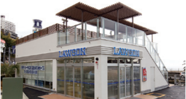
ローソン熱海サンビーチ店(静岡県) 設計事務所 株式会社上野山都市設計 建設会社 コスモ建設株式会社 販売店 浜松フロント株式会社 使用製品 NL300、NL400、FA120ドア
