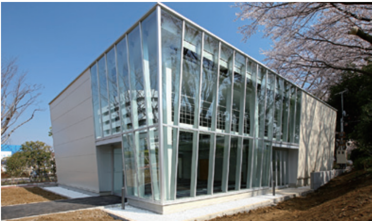
国立障害者リハビリテーションセンター ライフモデルルーム(埼玉県) 設計事務所 株式会社大場建築設計事務所 建設会社 株式会社イズミ・コンストラクション 加工店 株式会社エム・ファサード 使用製品 アソート
