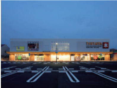
ドットとあーるzone前原(福岡県) 設計事務所 大和ハウス工業株式会社 福岡支店 建設会社 株式会社ブレインズ 加工店 株式会社旭シャッターサッシ 使用製品 アソート、NL400、FA120ドア、HD180ドア、回転窓(SP型)
