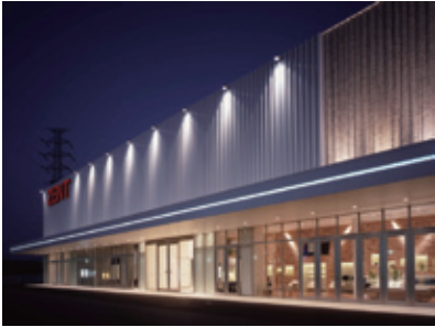
ZENT可児店(岐阜県) 設計事務所 (株)加藤吉宏アトリエ 建設会社 (株)フジタ 名古屋支店 販売店 日本デージー(株) 加工店 (有)伊藤サッシ工業 使用製品 NL400、FA120、LL520
