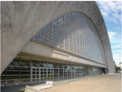
秋田スカイドームスライディングドア (広域公園工事UA14-K1) (秋田県) 設計事務所 (株)安部修一設計事務所 建設会社 珍田工業(株) 加工店 (有)ワダサッシセンター 使用製品 NL400、HD180、ハンガー引戸、 ステンレスフロント
