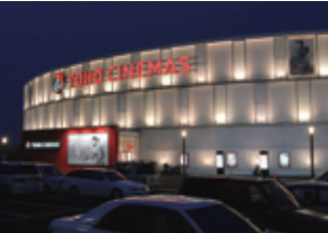
TOHOシネマズ ひたちなか (茨城県) 設計事務所 有限会社テクスチャー 販売店 株式会社スペース・ ゲット 加工店 有限会社サワチ工業 使用製品 NL300、NL400、昭 和ステンレスフロント
