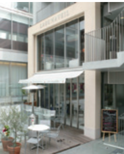
ラグナヴェール(東京都) 設計事務所 グラム 建設会社 有限会社ティール・ステップス 販売店 株式会社トーションサッシ 使用製品 オープンフロント
