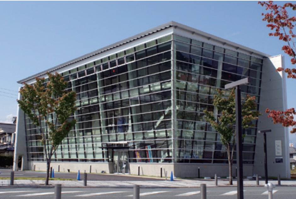
高橋眼科クリニック(山形県) 設計事務所 ビィフォックス株式会社 一級建築士事務所 建設会社 山形建設株式会社 加工店 有限会社成和フロント工業 使用製品 NL400、アソート、FA120 ドア
