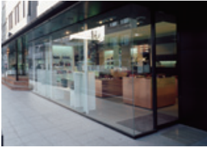
株式会社印傳屋 上原勇七 本店 (山梨県) 設計事務所 有限会社A.A.E. 一級建築士事務所 建設会社 株式会社パウハウス 丸栄 西日本本部 販売店 日硝株式会社 使用製品 昭和ステンレスフロント
