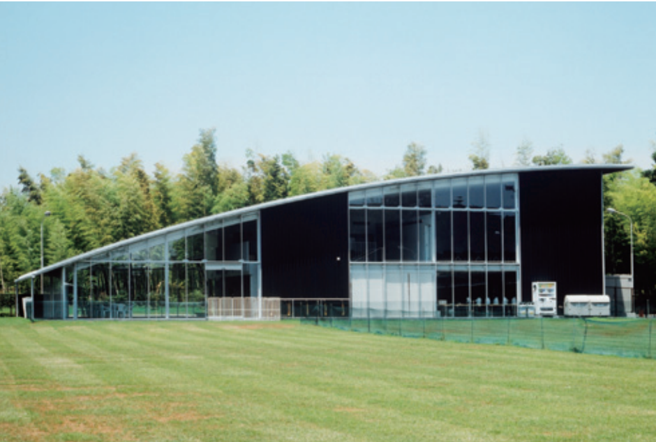
学校法人中村学園 長柄実習場 (千葉県) 設計事務所 株式会社ICAデザイン研究室 建設会社 松崎建設株式会社 販売・加工店 京葉アルミ建材株式会社 使用製品 ネオスリム、オープンフロン ト、SP回転窓
