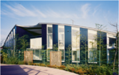
代田の切り通し(東京都) 設計事務所 有限会社ナスカー級建築士事務所 販売店 株式会社内山商会 使用製品 オープンフロント、昭和ステンレスフ ロント
