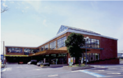
トヨタカローラ日進竹の山店(愛知県) 設計事務所 株式会社石田組 建設会社 株式会社松田建設 販売・加工店 旭硝子中日建材株式会社 使用製品 NL400、FA120ドア
