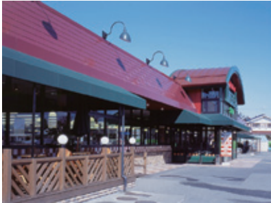
アップルランドデリシア梓川店(長野県) 建設会社 アルビコ建設株式会社 販売店 株式会社草間ガラス総合センター 加工店 有限会社コーワ建密 使用製品 NL300、NL400
