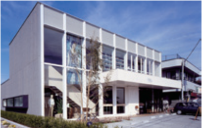
スポーティブ(神奈川県) 設計事務所 株式会社アクロス・ザ・ドア建築研究所 建設会社 株式会社門倉組 販売・加工店 シンワオートマチック株式会社 使用製品 NL300、オープンアトレ
