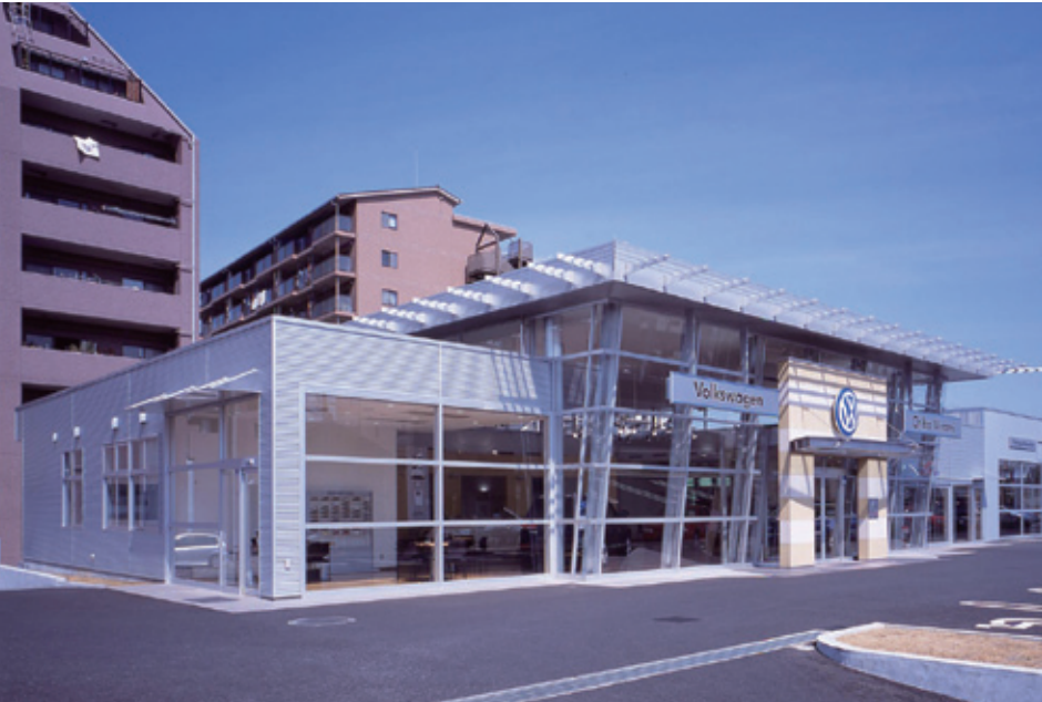
フォルクスワーゲン千葉南店(千葉県) 設計事務所 株式会社エムエスビー店舗 開発機構 建設会社 ヤシマ建設株式会社 販売・加工店 株式会社エム・ファサード 使用製品 ローライズコンボ、大型ハ ンガー引戸
