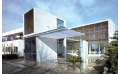
公園前にあるガレージハウス(岐阜県) 設計事務所 村瀬充アトリエ 建設会社 マルイ建設工業株式会社 販売・加工店 有限会社西濃ガラス 使用製品 NL300、オープンフロント
