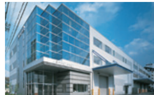
ルミナスセンタービル(愛知県) 設計事務所 大和ハウス工業(株) 名古屋支店 一級建築士事務所 建設会社 大和ハウス工業(株) 名古屋支店 (株)ケーエヌジー 加工店 ローライズBMC 使用製品
