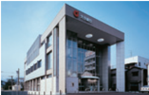
大分銀行 別府支店(大分県) 設計事務所 (株)青木茂建築工房 建設会社 佐伯・松浦建設共同企業体 加工店 (株)東洋サッシ工業 使用製品 ローライズコンボ
