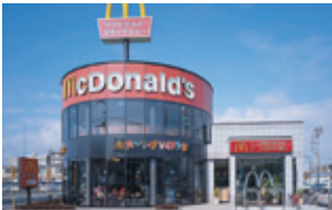
マクドナルド黄瀬川店(静岡県) 設計事務所 (株)フィールド 販売店 東海フロント(株) 使用製品 ローライズコンボ
