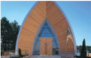
浜名湖ロイヤルホテルチャペル 「サン・ラ・ベール」(静岡県) 設計事務所 大和ハウス工業(株) 技術本部 大阪プロジェクトグループ 建設会社 大和ハウス工業(株) 技術本部 大阪プロジェクトグループ 使用製品 ネオスリム
