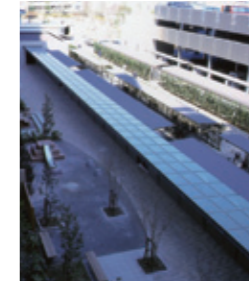
アイ・プレイス稲毛(千葉県) 設計事務所 長谷工コーポレーション(株) 建設会社 長谷工コーポレーション(株) 加工店 古川オール(株) 使用製品 ショーワスカイライト
