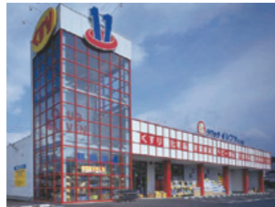
ドラッグイレブン永犬丸店(福岡県) 設計事務所 (株)ドラッグイレブン店舗開発室 販売店 (株)筑豊アルミセンター 加工店 (有)仙波アルミ工業 使用製品 ローライズコンボ、ショーワカラー ウェルネス
