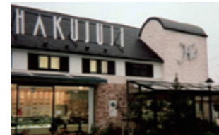
白十字 児島店(岡山県) 設計事務所 プリード湯谷(株) 販売店 (有)國弘サッシ商会 加工店 石邸アルミ建装 使用製品 NL400
