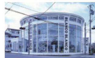
BLANCO G-South(岐阜県) 設計事務所 (株)ボーイ・カンパニー 販売店 第一技研(株) 加工店 (有)アルクラフト 使用製品 NL300、NL400
