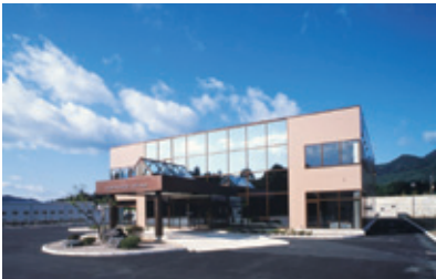
(株)キャメルマートジャパン社屋(岩手県) 設計事務所 (有)北設計 販売店 三正建設(株) 加工店 (株)トーワテクノス 使用製品 ショーワスカイライト、WICTEC
