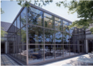
キリンバイト仙台(宮城県) 設計事務所 (株)丹青社 販売店 (株)鐵屋 加工店 (有)成和フロント工業 使用製品 WICTEC
