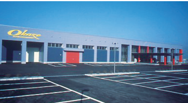
大風印刷 本社社屋(山形県) 設計 (株)アルモア建築・環境研究所 販売・加工 (株)ヤマト 使用製品 NL300、NL400、ローライズ2500F
