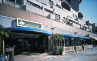
#7フィッシャーメンズグリル(東京都) 設計 南澤建設(株) 販売 古川サッシ(株) 加工 フロントセンター(株) 使用製品 NL300、オープンフロント
