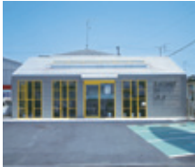
名古屋トヨベツト 上地営業所(愛知県) 設計 トヨタホーム名古屋 施工 旭シャッターサッシ 使用製品 NL300、NL400、 SD280ドアほか
