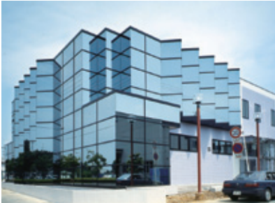
BIG HARLEY 高丘西店(静岡県) 設計 島津一級建築士事務所 施工 大嶋組 使用製品 NL400、スリムフロント、SD280ド アほか
