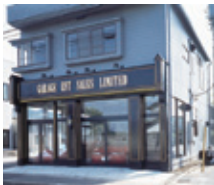
カーショップ ガレー ジェスト(埼玉県) 設計 しらゆき 施工 昭和建産 使用製品 NL300、NEW SK12 引戸、SD280ドアほか
