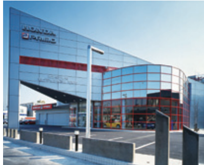
ホンダプリモ 笠寺店(愛知県) 設計 空水地工房 施工 アルミ加工センター ニノユ 使用製品 NL400、SD280ドア、スリムフロン トほか
