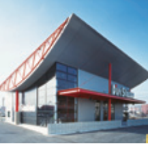
Disk Station (愛知県) 設計 入江設計室 施工 東鉄工業 使用製品 NL400、SD280ドア、 スリムフロントほか
