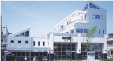
サイクルショップTORII(愛知県) 設計 畑田建築設計室 施工 加藤アルミ販売 使用製品 NL400、SD280ドアほか
