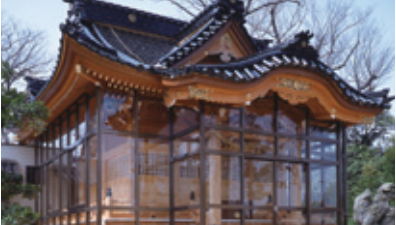
神田神社(石川県) 設計 山本工務店 施工 ライフボックス三和 使用製品 NL400ほか
