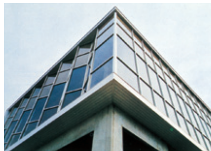
住宅販売会社 近畿土地株式会社 本社(京都府) 施工店 株式会社鐵工社フル 使用材料 ナローライン300、400、450
