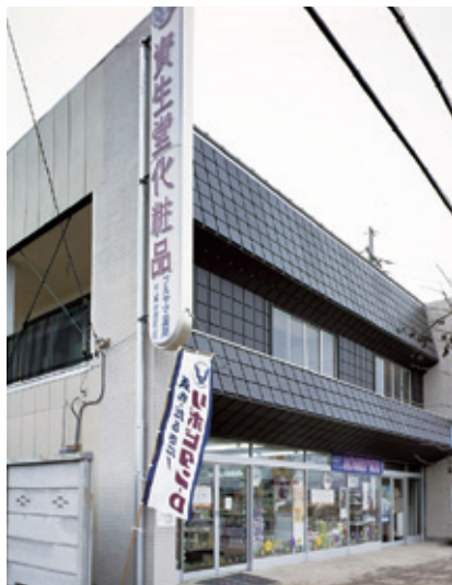
薬店 古山薬局(千葉県) 施工店 大旺興業株式会社 使用材料 ナローライン300、400、190ドア、カラール
