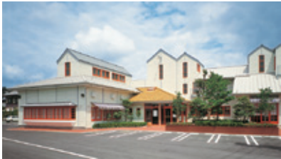
レストラン あさくま半田店(愛知県) 設計 マクセン企画室 施工 (株)旭シャッターサッシ 使用製品 NL300、SD260、AD格子、HD180ケースメントほか
