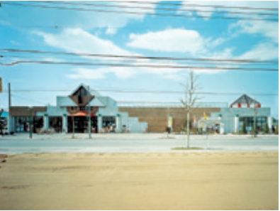
スーパー サンドール伏古店(北海道) 設計 (株)船場札幌営業所 施工 (株)北製作所 使用製品 NL300、NL400、Gフロント、SD260ほか
