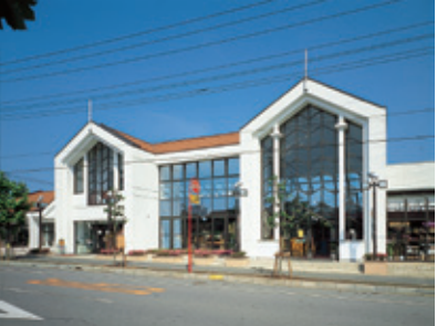
スーパー ヤックス(千葉県) 設計 (株)新田守彦建築研究所 施工 三井建材(株) 使用製品 NL300、NL400、CW2500、SD260ほか
