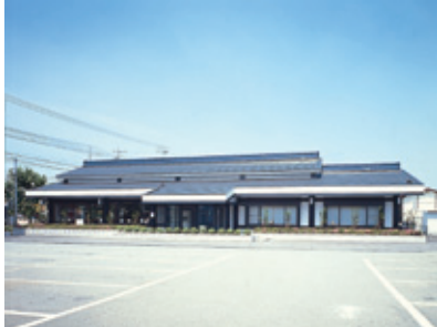
レストラン さと(兵庫県) 設計 ミサワ建築設計事務所 施工 ゴバン塗装 使用製品 NL300、NL400、AD格子、SK12ほか
