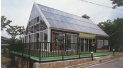
レストラン 薮の里(栃木県) 設計 松永建築設計事務所 施工 (株)三好 宇都宮支店 使用製品 NL300、NL400、SK12、CW2500ほか
