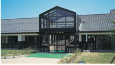
集会所 農林漁業体験実習室(長野県) 設計 (株)新日本建築設計事務所 施工 (有)中信ガラスサービス 使用製品 NL300、SK12、SD260、SR300ほか
