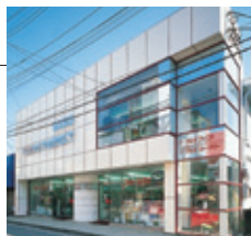
薬局・本屋 久留米ファーマシー(東京都) 設計 (株)丹青社 施工 (株)エース 使用材料 NL300
