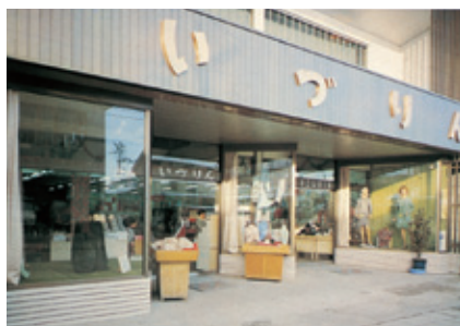
洋品店 いづりん(栃木県) 施工店 有限会社三井建装 使用材料 ナローライン300、400、450
