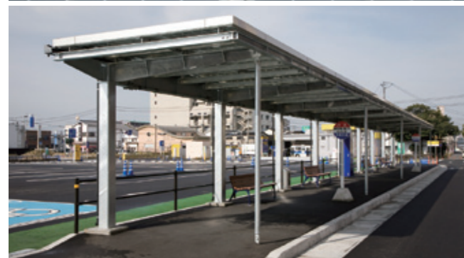
「ソーラーパネル組み込み型アルミフレーム」 バス停、駐車場、アーケードの屋根などに 施工例が増えている。
