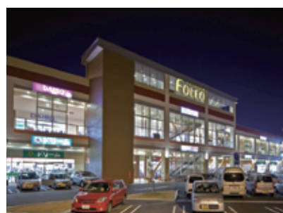
フォレオ広島東ショッピングセンター(広島県) 設計事務所 大和ハウス工業株式会社 広島支店 一級建築士事務所 建設会社 大和ハウス工業株式会社 広島支店 加工店 株式会社サンケンフロント 使用製品 アソート、FA120ドア
