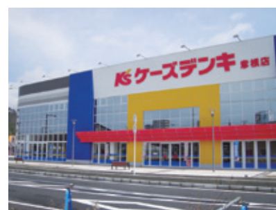
ケースデンキ彦根店(滋賀県) 設計事務所 有限会社愛北総合事務所 高島建築設計 建設会社 株式会社土屋組 加工店 愛岐サッシ工業株式会社 使用製品 アソート、NL400、FA120ドア、HD180ドア
