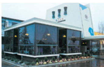
レストラン 月の輪(福島県) 施工 野沢建装(株) 使用材料 ナローライン300、400
