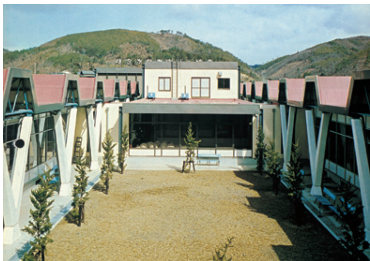
メリヤス工場 藤部メリヤス佐用工場(兵庫県) 施工店 みつの店飾 使用材料 ナローライン300、400、450、SK11引戸、700K
