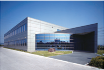
ヘキスト合成(株)静岡研究所(静岡県) 設計 須山建設(株) 東遠支店 販売 (株)村上開明堂浜松支店 加工 (有)佐々木サッシ 使用製品 ローライズBMC
