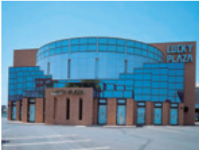
ラッキープラザ清水店(静岡県) 設計 オフィスコスモ三津原 建築事務所 販売 (株)村上開明堂 加工 静岡アルミ(株) 使用製品 スリムフロント
