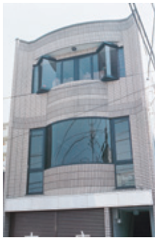
店舗併用住宅 I・S・K 武蔵野(東京都) 設計 横山彰人建築設計事務所 施工 大畑硝子建材 使用製品 NL300、HD180ケー スメントほか
