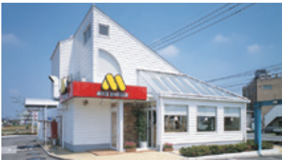
ハンバーガーレストラン モスバーガー川越山田店(埼玉県) 設計 長谷川敬アトリエ 施工 佐々木ガラス 使用製品 NL300、SK12、HD180、SP回転窓、Gフロントほか
