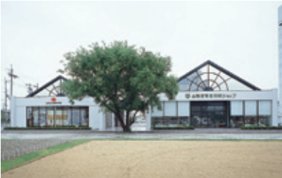
ギフトショップ・パン店 山陽百貨店別府ショップ(兵庫県) 設計 大和ハウス工業 姫路支店 施工 ミズノ 使用製品 NL300、NL400、SD280、SP回転窓ほか
